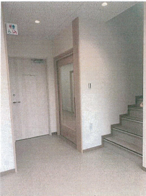
1F エントランスホール
