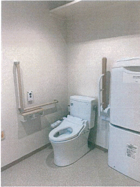
1F 車いす用トイレ
